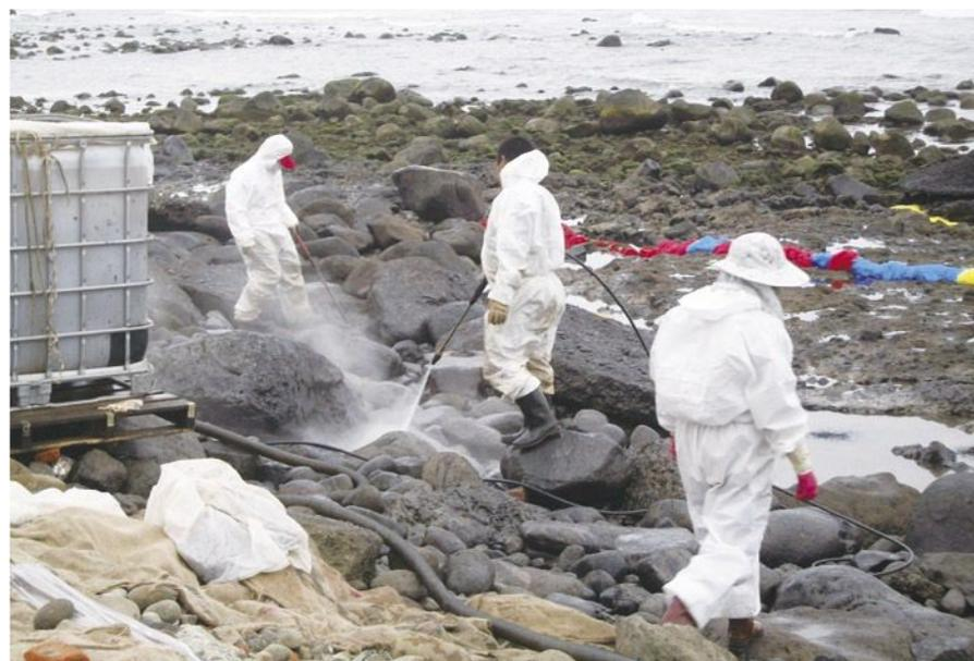
各縣市環保局支援的14台高溫高壓清洗機及2台高壓清洗機皆已投入岸際清洗油污利用高壓水柱沖先洗黏附在岸際岩石上的殘油。
